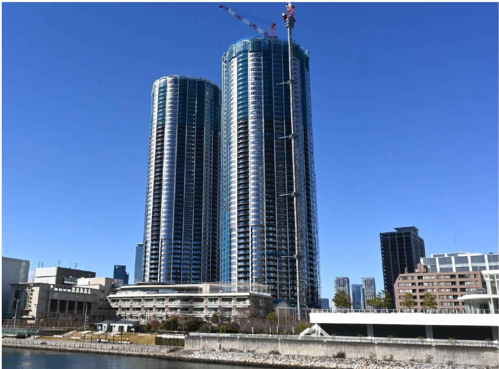
建築工事中の「ザ豊海タワーマリン&スカイ」(中央区豊海町41番(地番)地上53階
