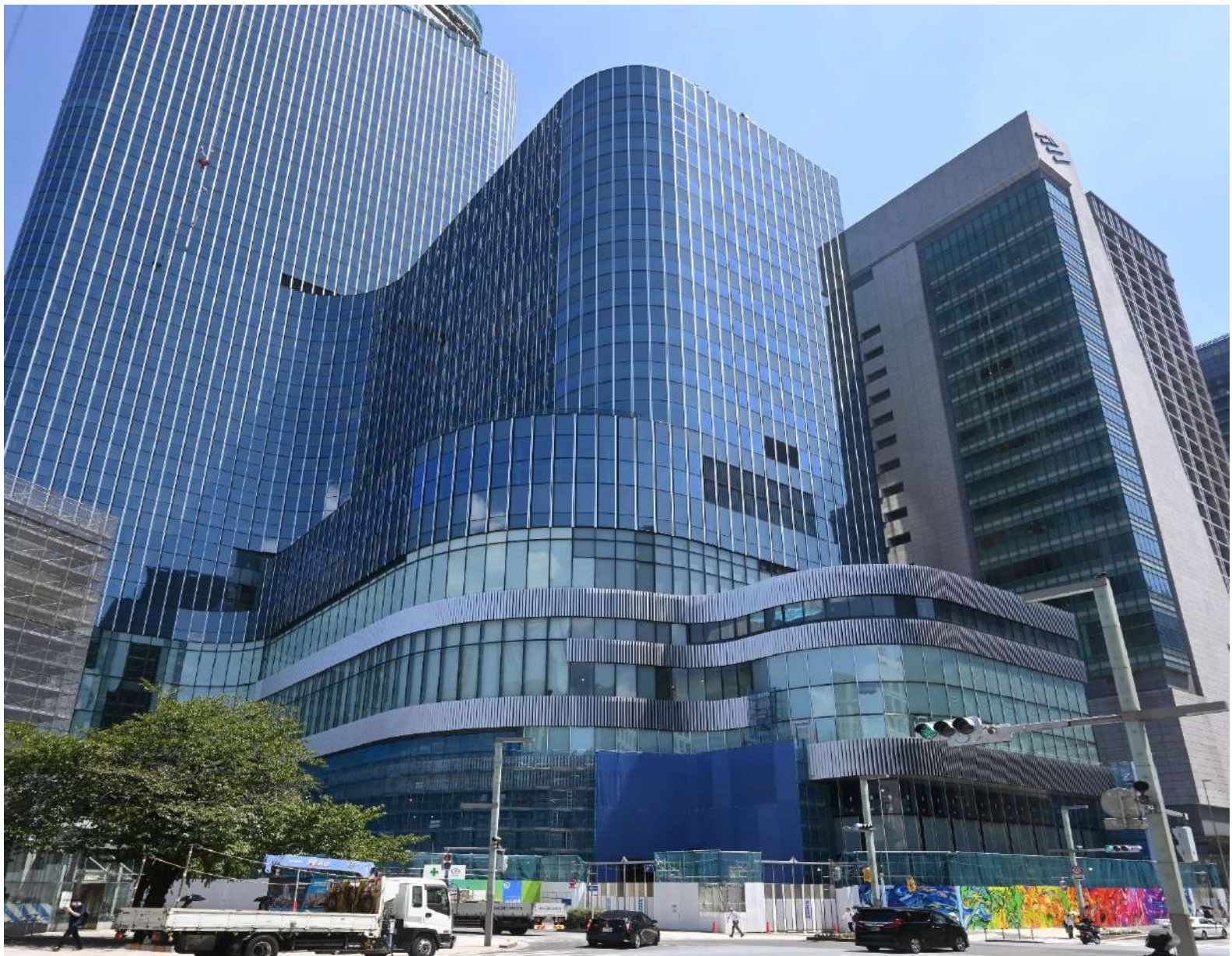
日本橋近くに、オフィス、商業施設、ホテル、居住施設、MICE施設、ビジネス支援施設などで構成する地上52階、地下5階、高さ283.96m（最高283.96m）、延べ面積374,003㎡の超高層ビルが2026年3月竣工する予定のようです。建築中の工事用仮囲いの一部が色彩豊かに輝いて居るのが見えます。（中央区日本橋1-30-32）
